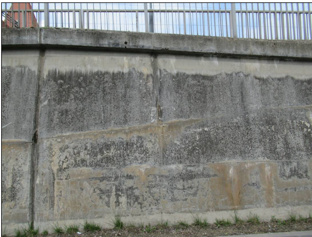
Obr. č. 13 – pohled na 2. část zdi z monolitického betonu z komunikace - viditelné podélné trhliny procházející zdí
