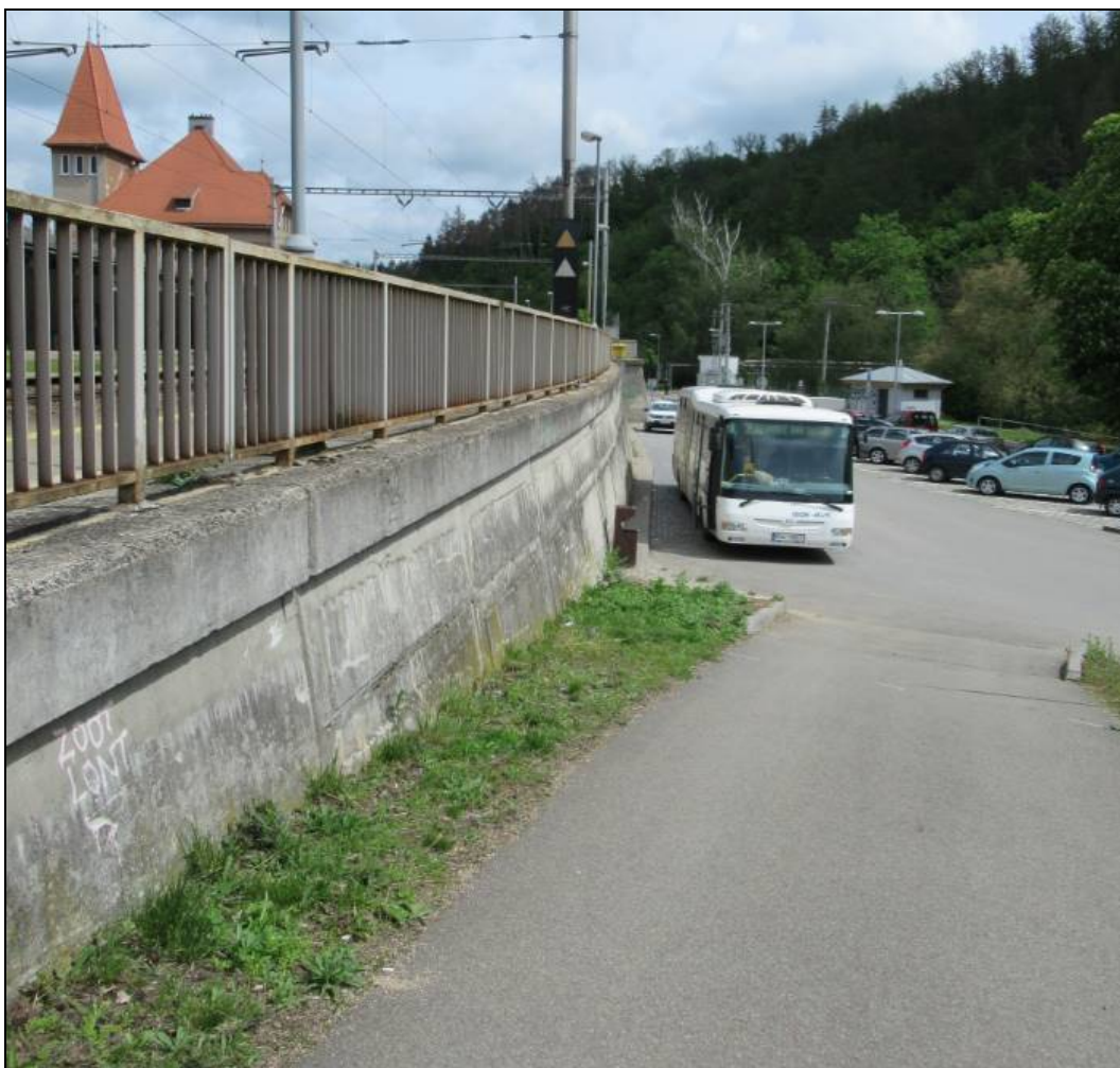
Obr. č. 9 – pohled na 1. část opěrné zdi z prefabrikovaných dílců zleva (vedoucí podél autobusového stanoviště)
